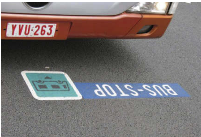
Foto 7: MIVB, markering voor stop aan de bushalte op het wegdek (halte Geneve te Evere).
